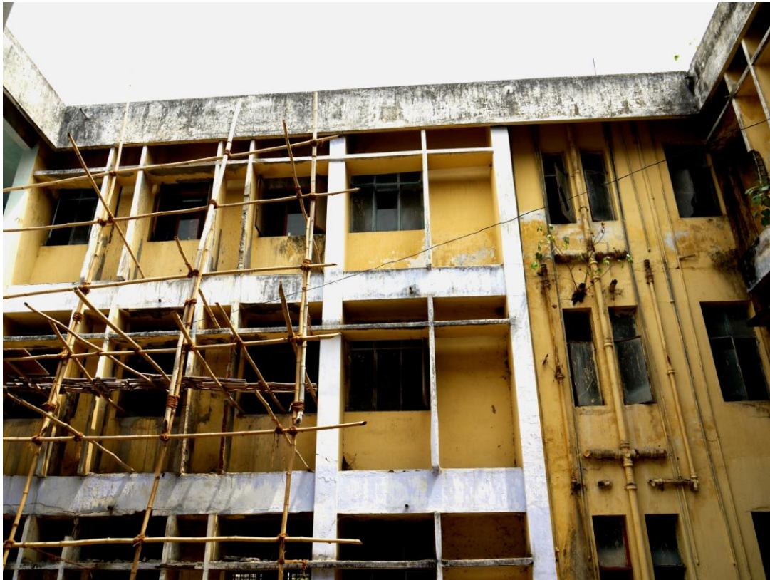
Un bâtiment de l'hôpital de Gaya.
